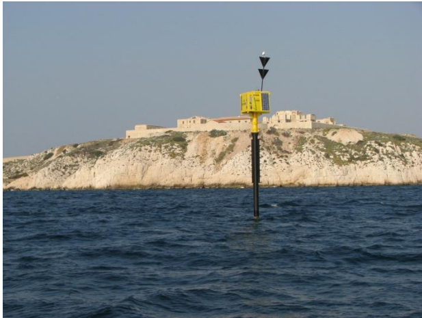
Marque cardinale Sud entre Frioul et Château D' If : signale une roche au Nord recouverte de 2,5 m d'eau
